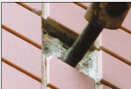
写真5 タイルの補修が必要
