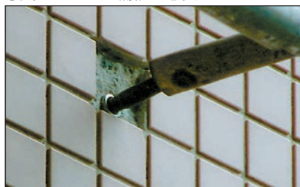
写真5 タイルの補修が必要
