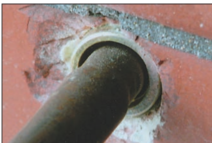
写真3 錆ダレが生じる
